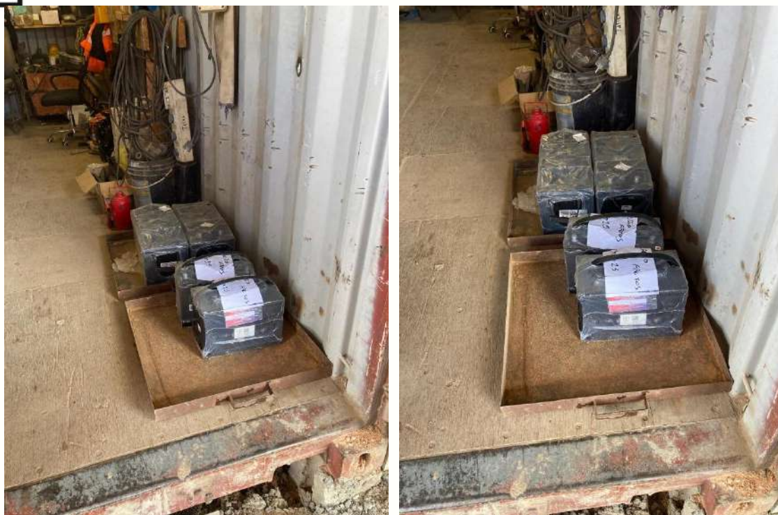
Foto N°1 y 2: Bandejas debajo de baterías, por posibles derrames.
